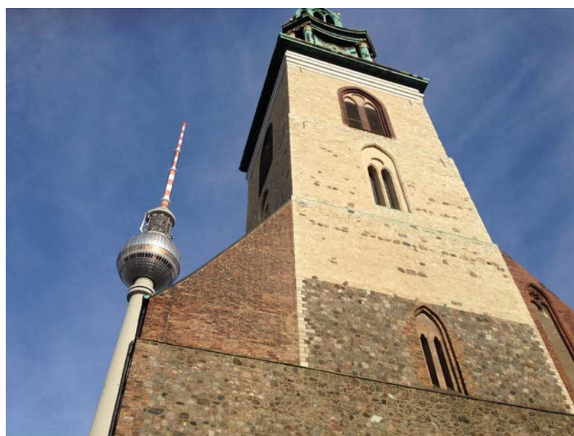
FOTOS 4 – Blick auf den Turm der Marienkirche aus Rüdersdorfer Kalkstein. Im unteren Teil sind auch die verwendeten Feldsteine sichtbar.
