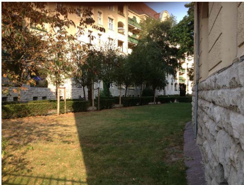
FOTO 6 – Blick in die „Helenenhöfe“. Im Vordergrund rechts die verwendeten Rüdersdorfer Kalksteine
