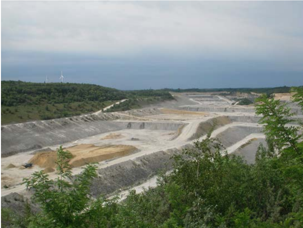
Blick in den Kalksteintagebau der Cemex Zement GmbH
