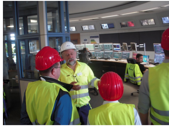
In der Schaltwarte des Zementwerkes
